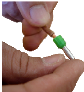
شکل ۱۵: مراحل کریمپ کردن سر سیمها
